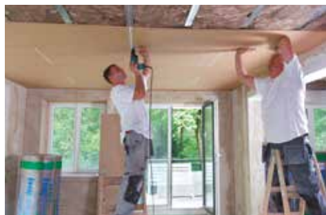
Knauf SILENTBOARD – akustický pohled
