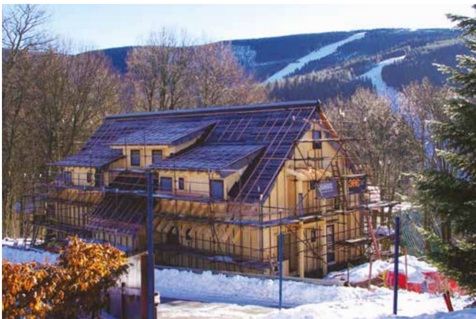
Průběh výstavby budovy penzionu
