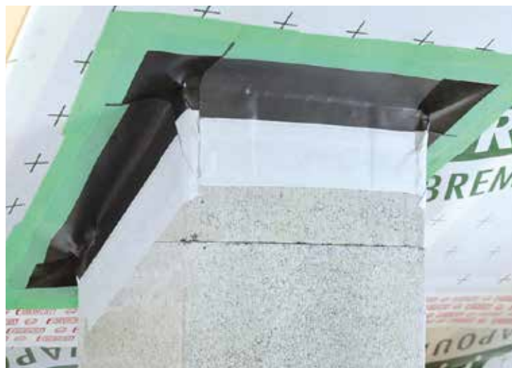
Napojovací sada pro parozábranu na komín
