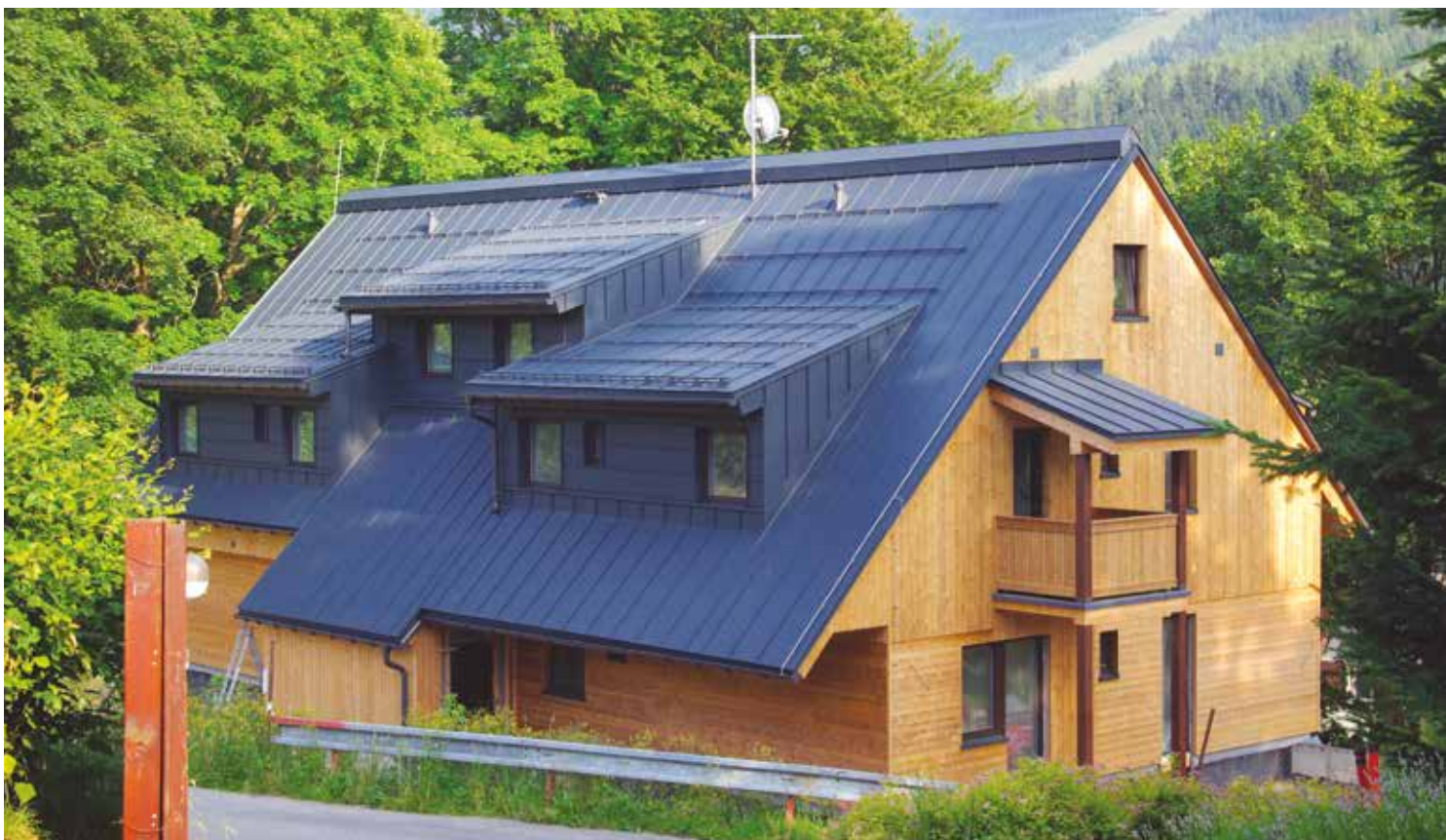
Dům těsně před požárem
