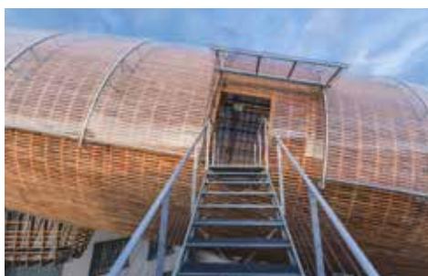
Vruty WT v konstrukci a v opláštění vzducholodi Gulliver v Praze
