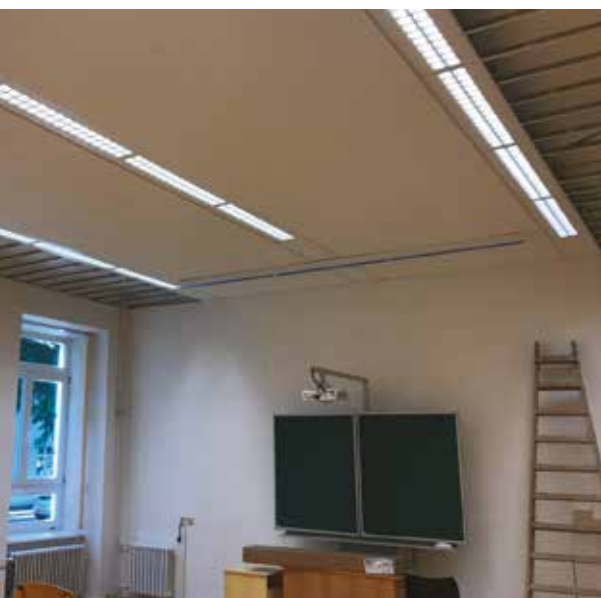
Učebna v ZŠ Mikołáše Alše v pražském Suchdole před rekonstrukcí
