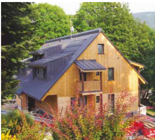
Dům těsně před požárem
