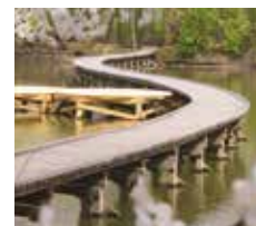
Vruty WT v konstrukci naučné stezky přes rybník ve Vestci u Prahy
