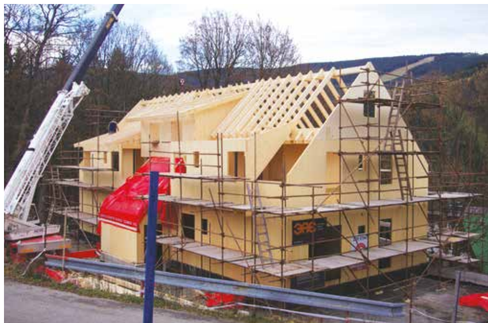
Průběh výstavby budovy penzionu
