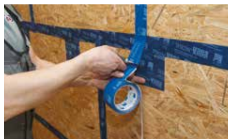
Vzduchotěsnost dřevostavby na 100 let zajistí systémy pásek a manžet pro clima
