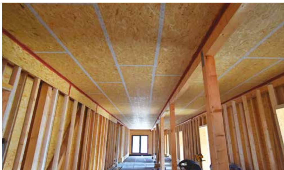
Parobzda z OSB desky 3 15N-4PD lepené ve spárách s přepáskováním
