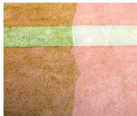
Aplikací ochranného samočisticího fotokatalytického systému FN NANO dochází k zamezení vzniku a růstu mechů, lišejníků, řas a plísní na fasádě
