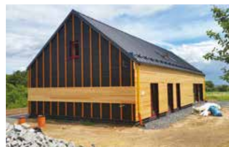
Dřevěné opláštění domu v Panenském Týnci
