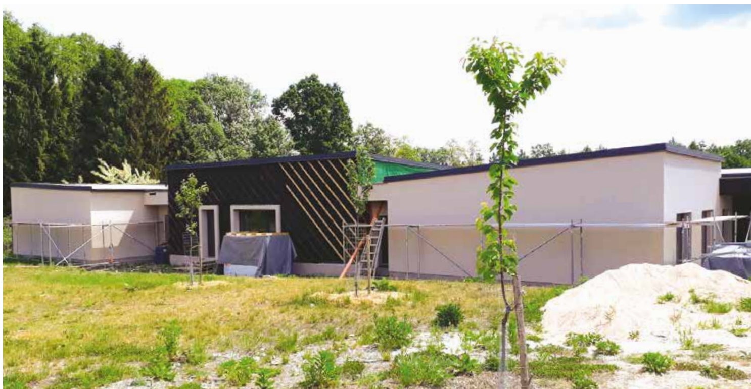
Současný stav výstavby Komunitního domu
