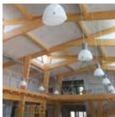
Kulturní dům Ratíškovice a pohledové spoje dřevěné konstrukce
