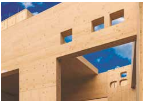
Čisté detaily, staticky pevná, stabilní a masivní konstrukce
