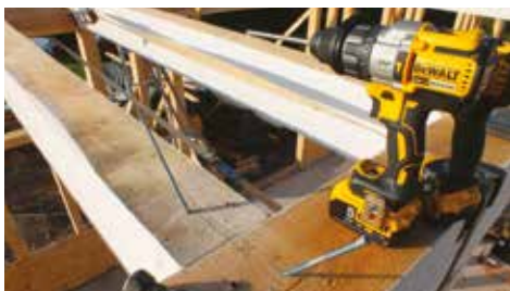
Rozměřené a pod úhlem 45 stupňů zašroubované dvouzávitové konstrukční vruty WT
