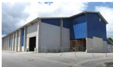
Sklad soli byl postaven v průmyslové zóně obce Ostrach
