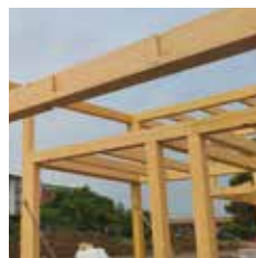
Montáž vaznic do rybin a upevňovacími vruty WT v projektu Obecní dům Praha-Ďáblice
