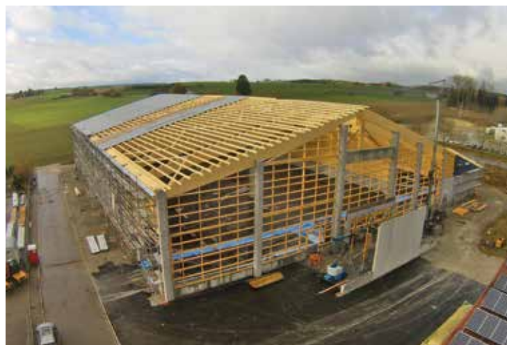
Dřevostavba byla zvolena z důvodu odolnosti dřeva vůči soli
