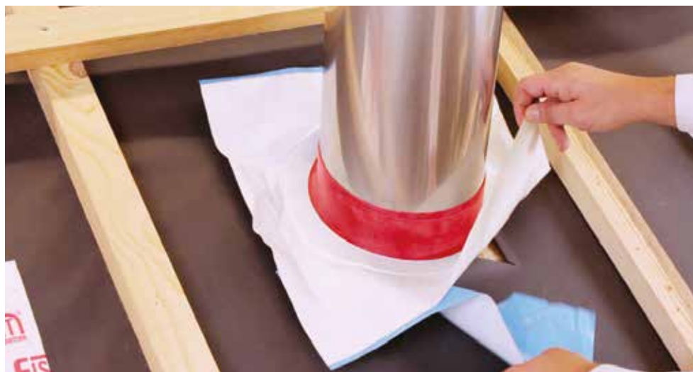
Manžeta s teplotní odolností 250 °C pro napojení nerezového komínu
