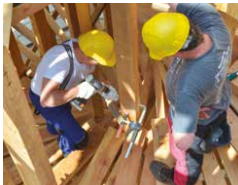
Spoje sloupků v projektu rozhledny Heřmanice
