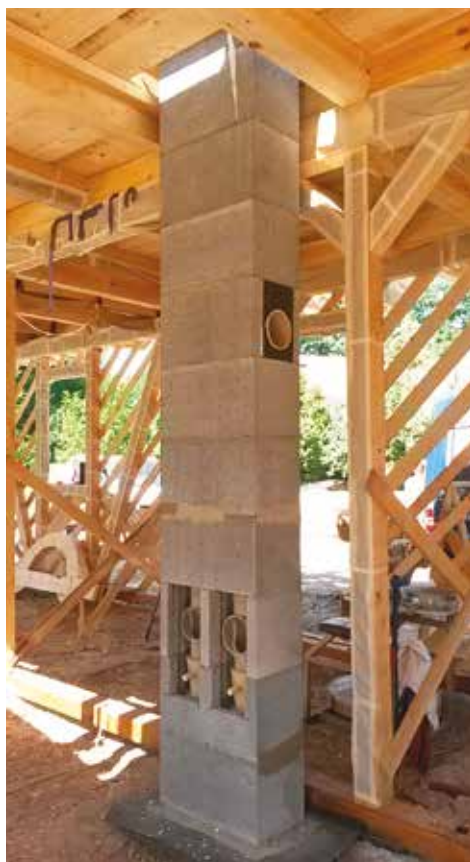
Prefabrikovaný komín v montované dřevostavbě
