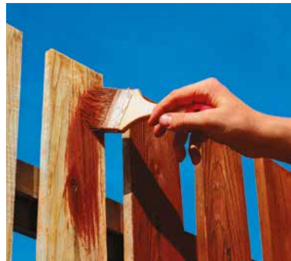
Nátěr impregnačním přípravkem s indikační hnědou barvou je pro neprofesionály ideálním řešením Foto Shutterstock
