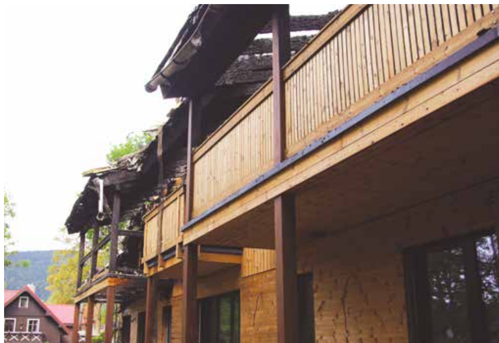
Jižní strana domu s přesahy balkonů
