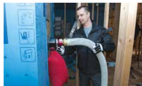
S malým montážním otvorem a hadicí se zateplí obvodové stěny dřevostavby za několik hodin.
