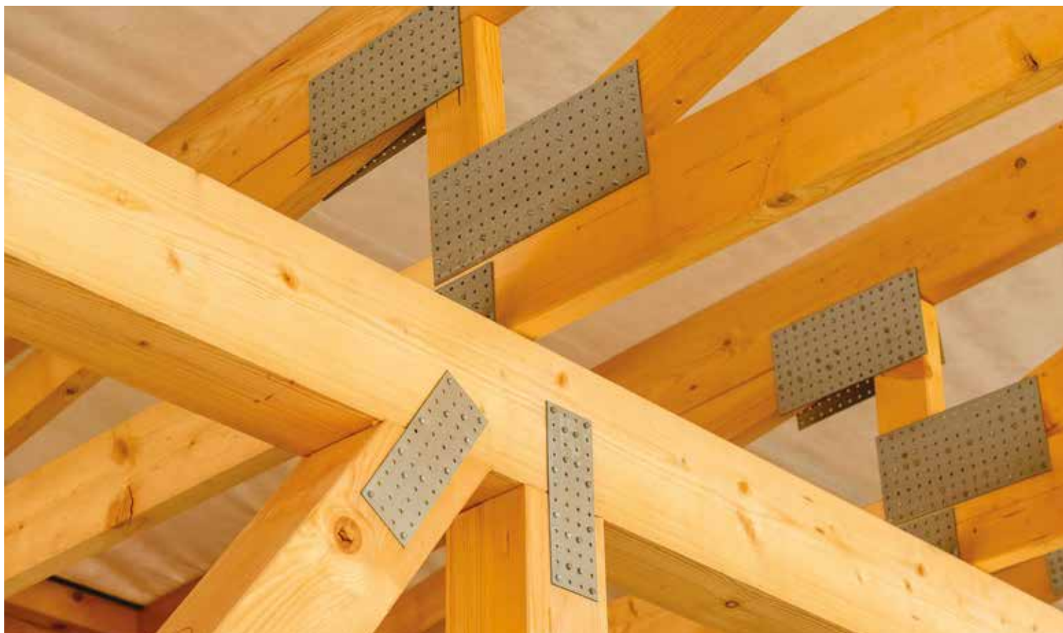
Detail spojů nosné konstrukce vybraných domů Atea
