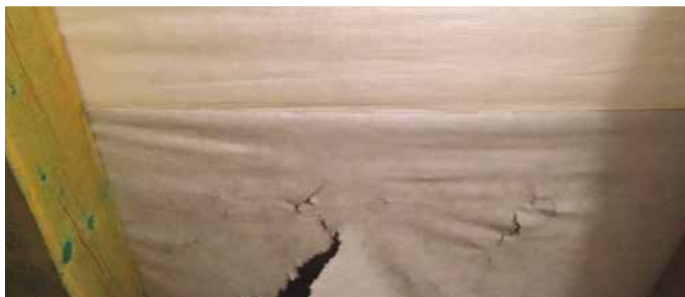
Třívrstvá mikroporézní fólie 135 g/m 2
