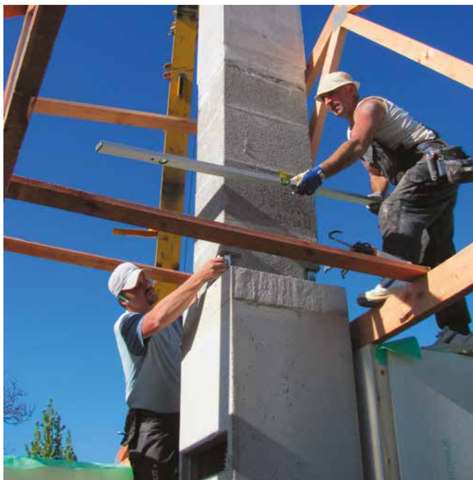
Termoizolační tvárnice slouží k přerušení tepelného mostu
