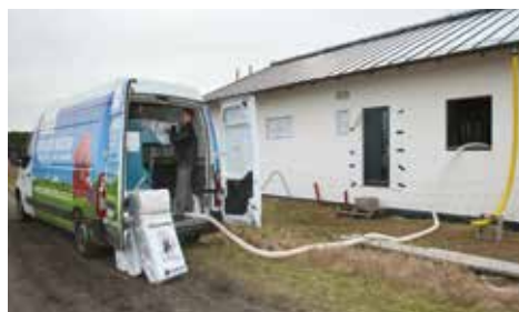
Izolace domů s foukanou celulóзовou izolací.
