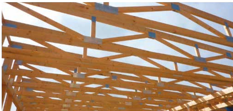
Detail spojů nosné konstrukce vybraných domů Atea
