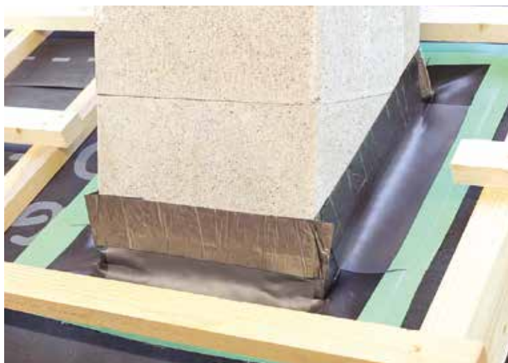
Napojovací sada pro střešní fólii na komín
