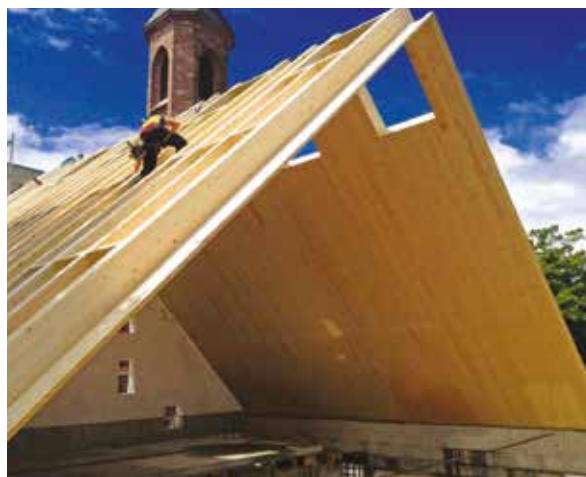
Velké rozpory elementů, vysoký stupeň prefabrikace, kombinace i s jinými systémy
