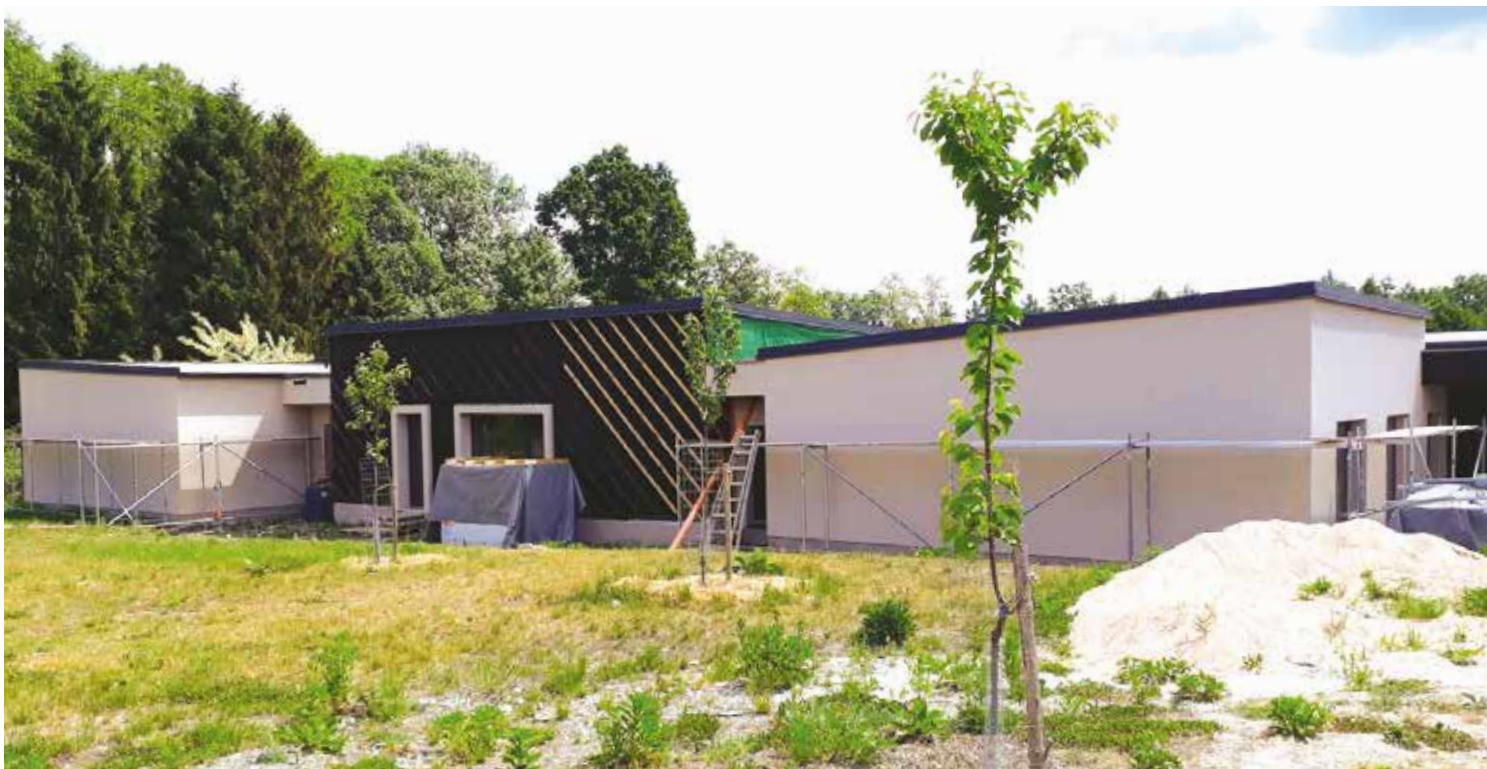
Současný stav výstavby Komunitního domu
