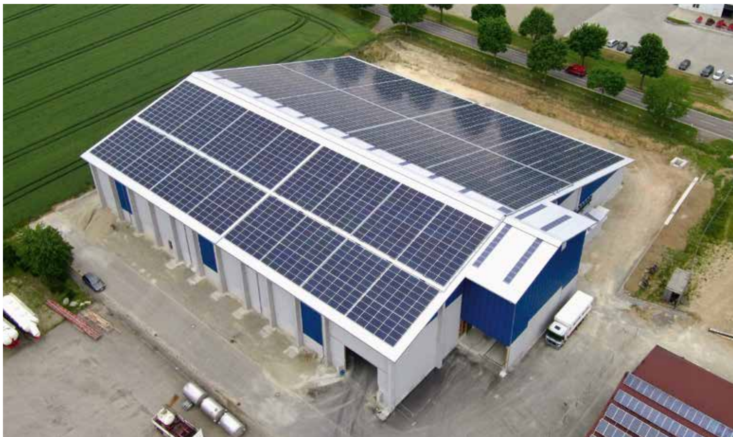
Celý povrch střechy skladu soli byl vybaven fotovoltaickým systémem
