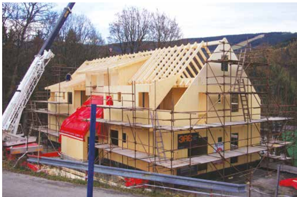
Průběh výstavby budovy penzionu
