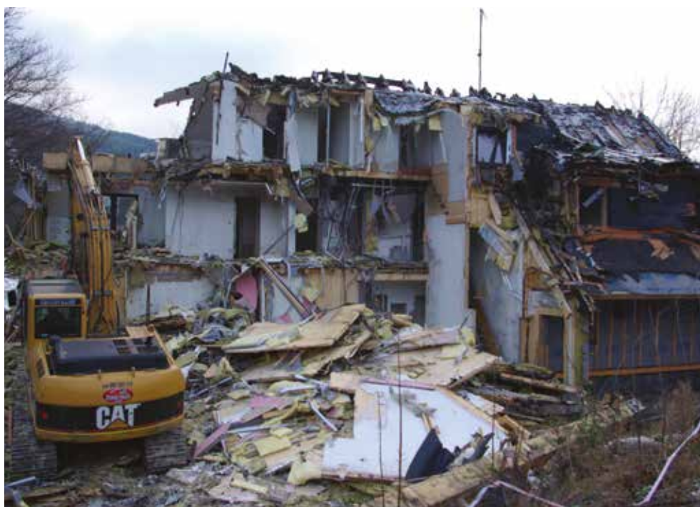
Především kvůli poškození vodou bylo nakonec potřeba dům strhnout
