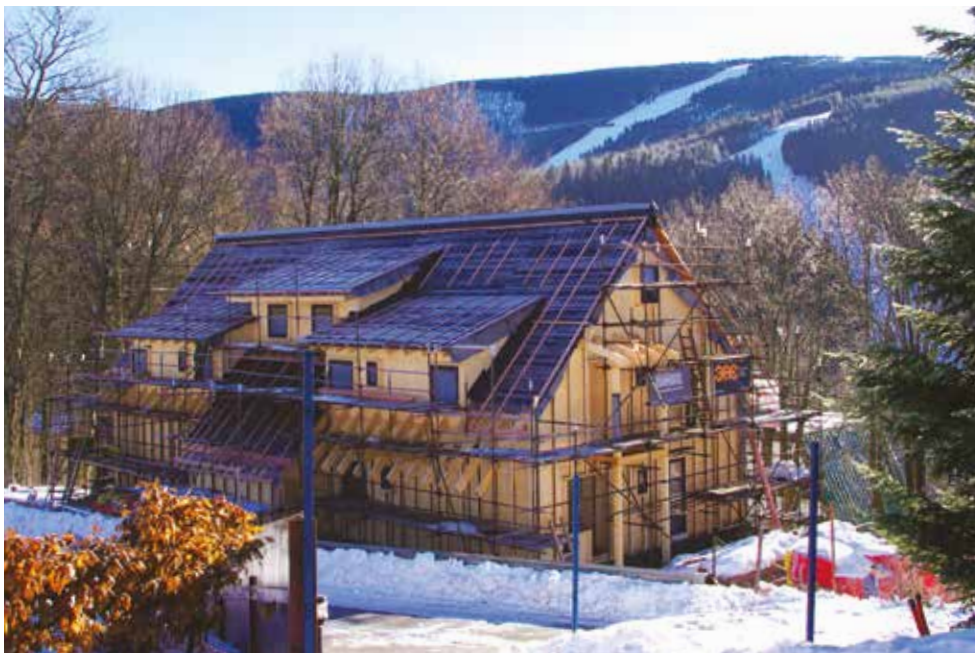
Průběh výstavby budovy penzionu
