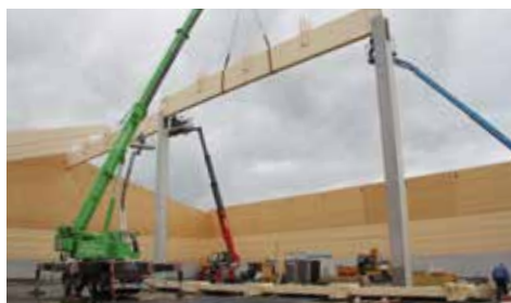
V novém sklad soli bylo instalováno více než 2 000 m 2 OSB 4 TOP desek
