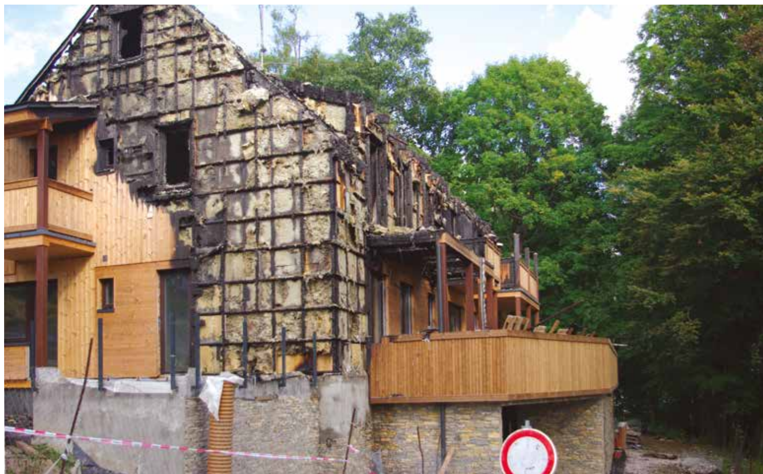
V rámci zachraňovacích prací bylo potřeba odstranit všechny konstrukce, které ohrožovaly okolí, především přesahy balkonů
