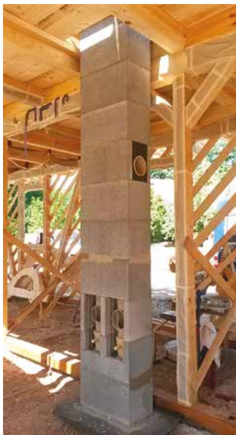
Prefabrikovaný komín v montované dřevostavbě
