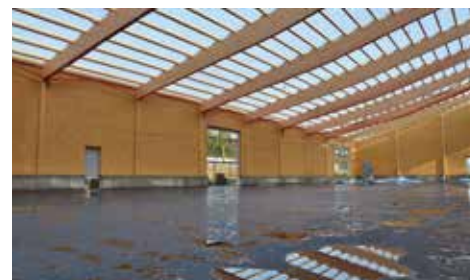
Desky EGGER OSB 4 TOP byly použity pro obložení stěn
