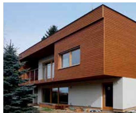
Vodorovný obklad Thermowood
