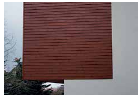
Detail napojení vodorovného obkladu Thermowood na omítku
