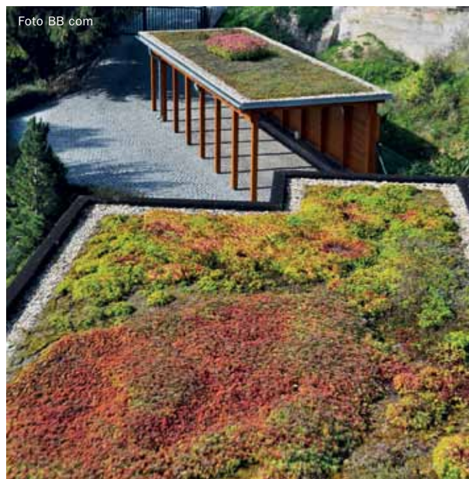
Extenzivní rozchodníková rohož určená pro realizaci zelených střech. Výrobce Sedum Top solution s.r.o. Substrát BB Com s.r.o.
