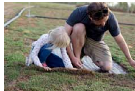
Extenzivní rozchodníková rohož určená pro realizaci zelených střech. Výrobce Sedum Top solution s.r.o. Substrát BB Com s.r.o.
